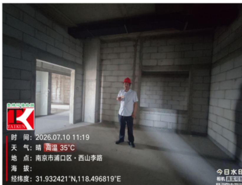
工程师现场踏勘照片②
