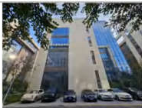
本项目拟建址西侧（10 栋）
