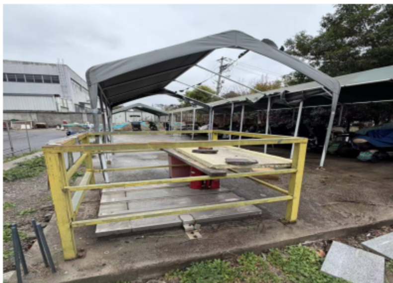
图4-2 事故池现场照片
