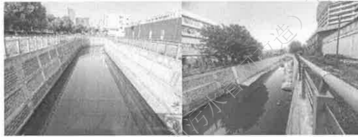
图 3-8 朱家河河道现场照片
