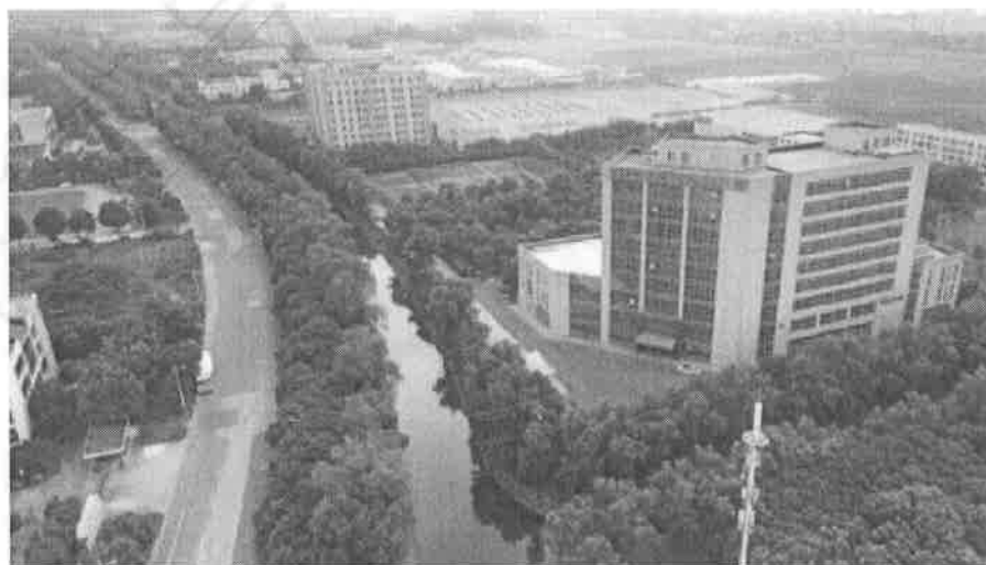
图 3-1 五号街沟现状
