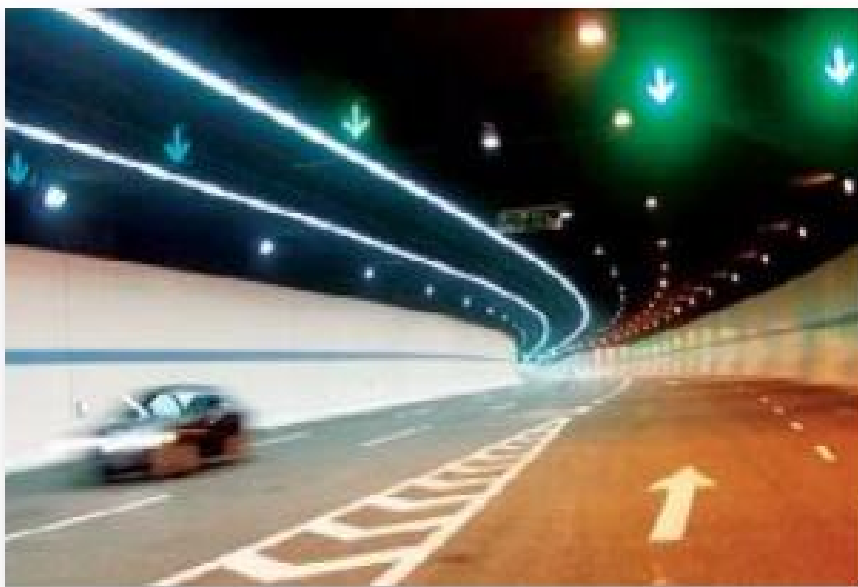
图 3-4 现状九华山隧道
