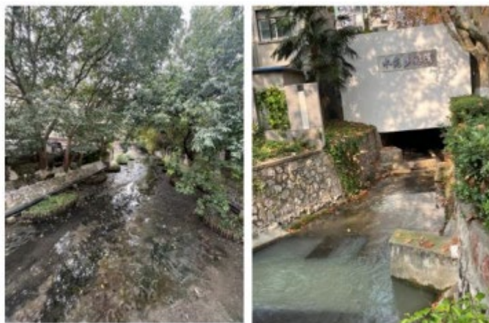
图 3.1-2 友谊河西沟暗涵现状照片
