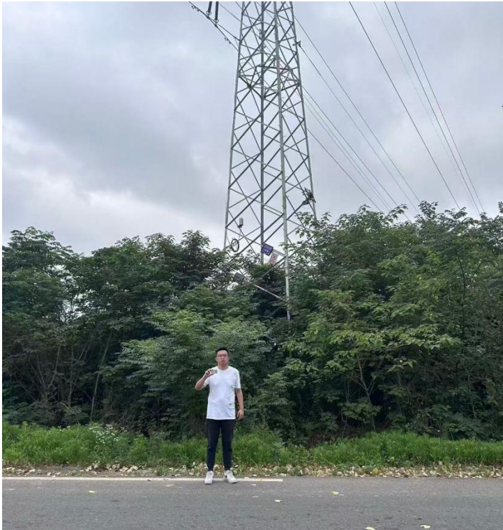
工程师现场踏勘照片
