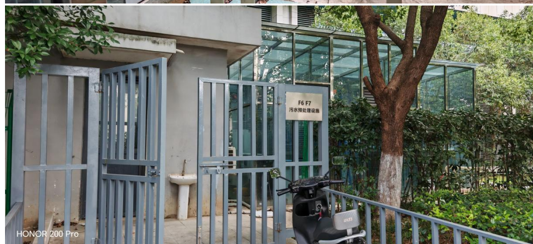
现有项目依托的园区污水预处理设施
