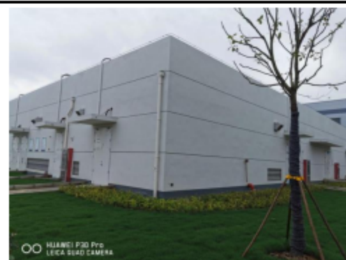
危废暂存库外部现状
