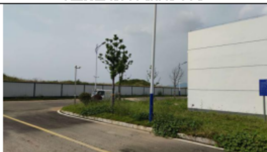
危废库外部监控
