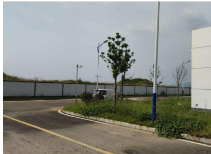
危废库外部监控
