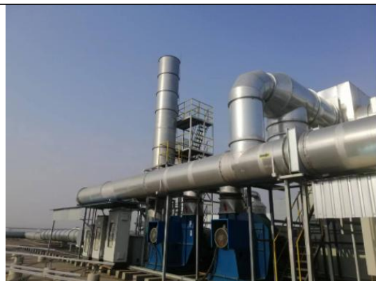
2#袋式除尘+沸石+RTO 装置+FQ-2 排气筒
