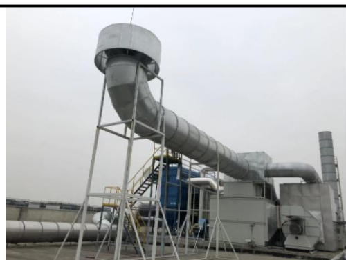
1#袋式除尘+沸石+RTO 装置+FQ-01 排气筒
