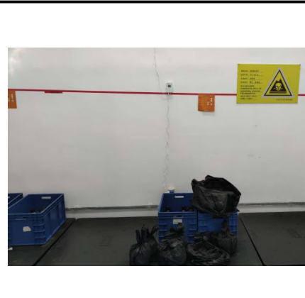
危废暂存库内部标识等
