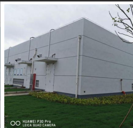
危废暂存库外部现状
