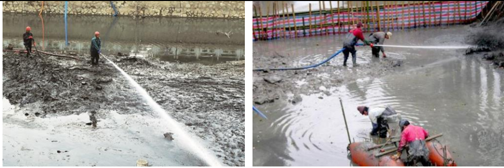
图2-4 水力冲挖清淤示意图
