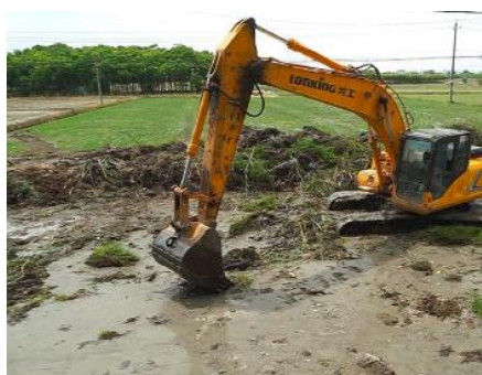
图 2-6 河道干挖清淤示意图（左）及渣土车示意图（右）
