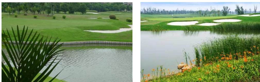
图 2-7 草坡入水护岸示意图
