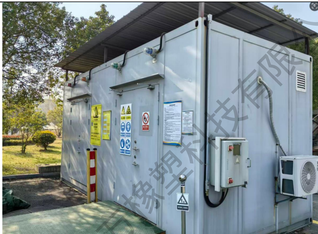
现有一座 20m 2 危废库
