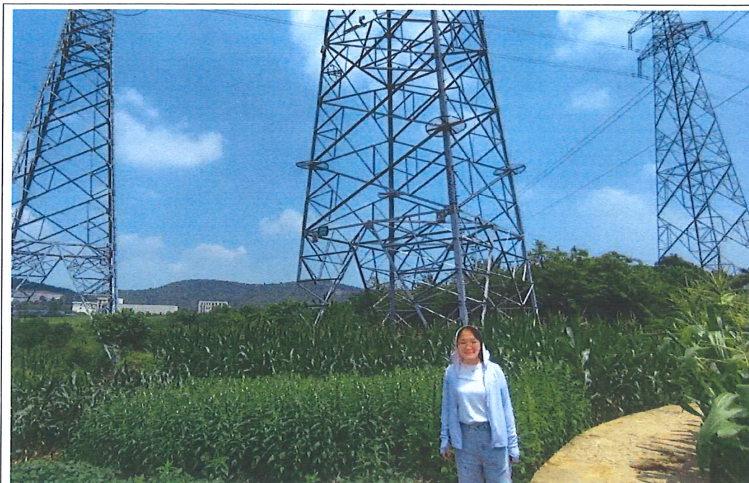
拍摄时间：2025 年 08 月 20 日 拍摄地点：110kV 阳后 2#45#塔附近 工程师现场照片
