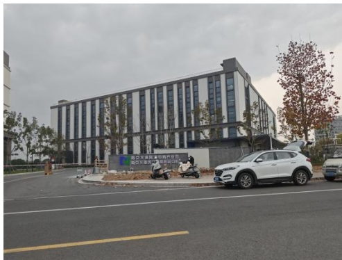
工矿仓储用地
