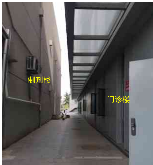
图 8-10 医技楼东北侧制剂楼
