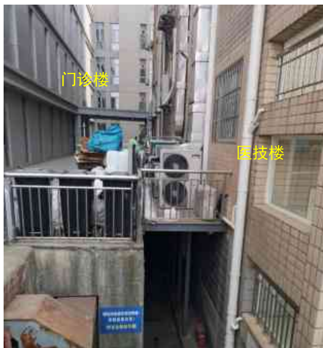
图 8-9 医技楼东侧、南侧门诊楼
