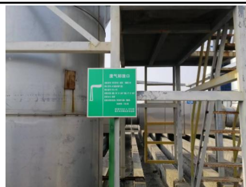
1#袋式除尘+沸石+RTO 装置+FQ-01 排气筒
