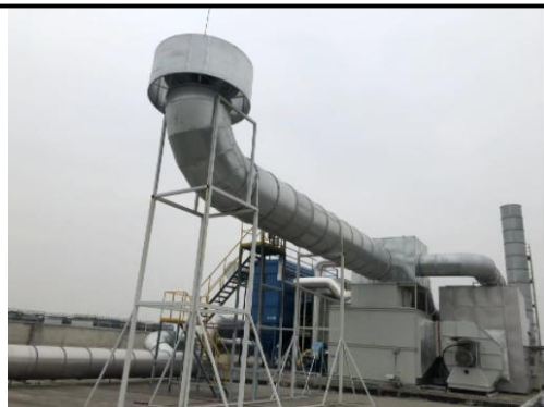
1#袋式除尘+沸石+RTO 装置+FQ-01 排气筒
