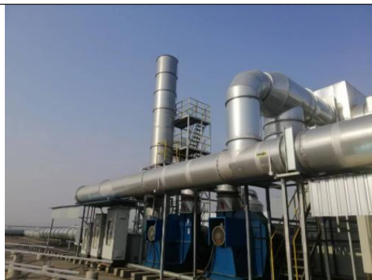
2#袋式除尘+沸石+RTO 装置+FQ-2 排气筒
