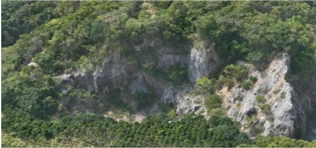
图 3-5 A4 区边坡现状图
