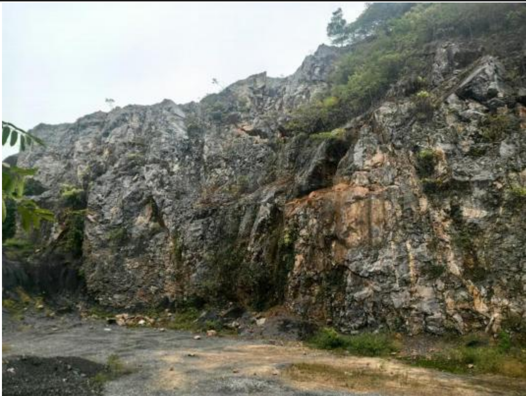
图 3-4 A3 区边坡现状图
