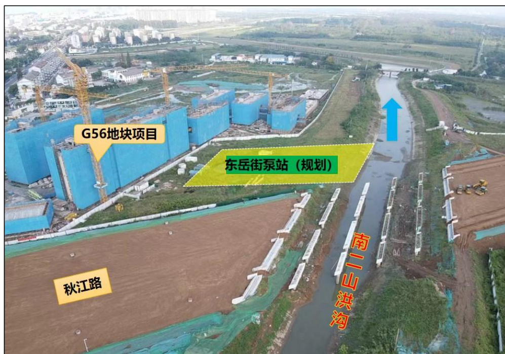
图 3-2 东岳街泵站建设工程现状图
