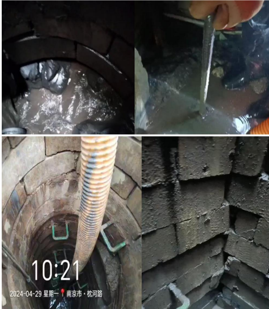
图 3-9 枕河路污水管网现状
