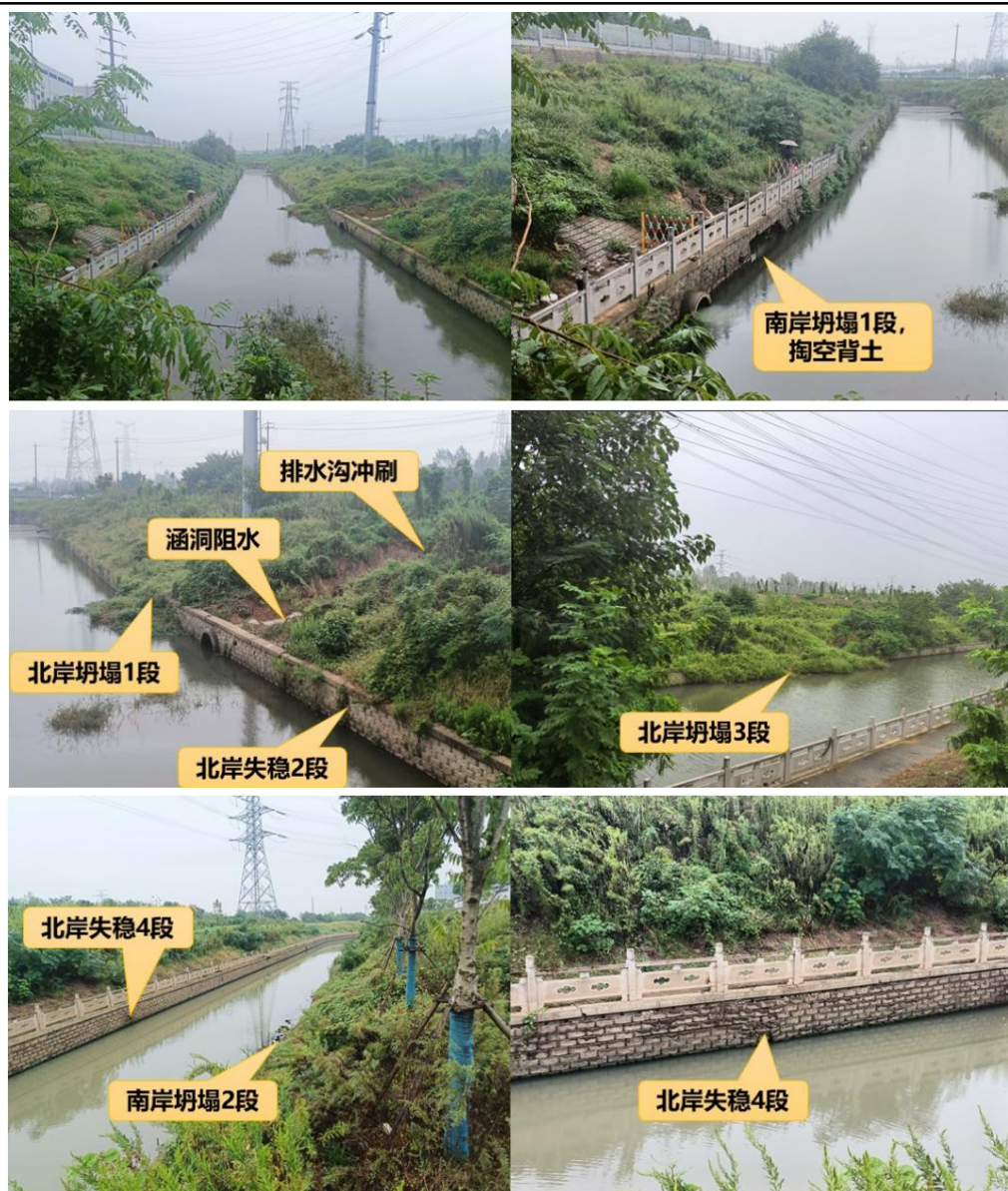
图 3-5 阑珊河消险加固工程现状
