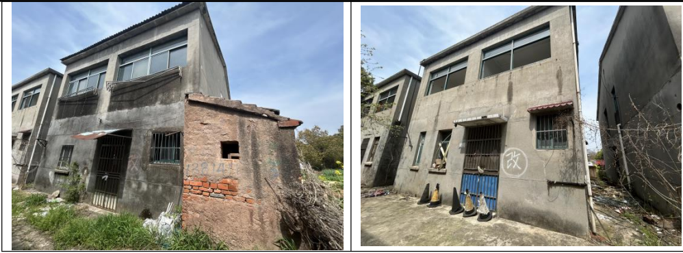
图 3-2 林场退休员工宿舍棚户区改造后空置建筑物现状（部分）
