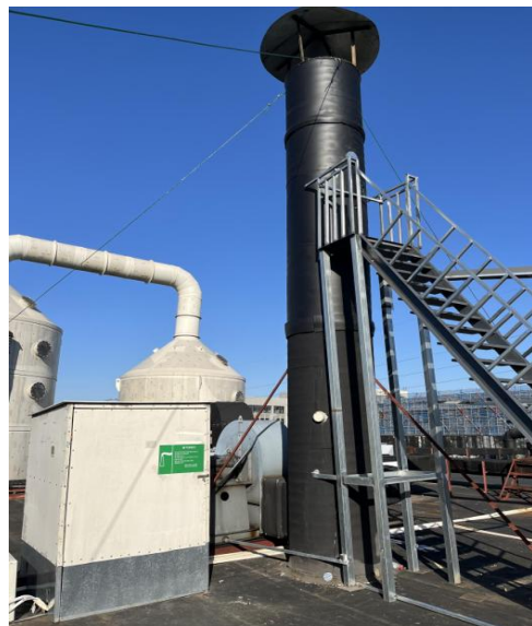
水喷淋+除雾+活性炭废气处理装置
