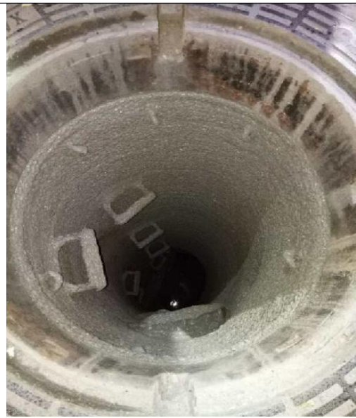
污水检查井修复过程照片
