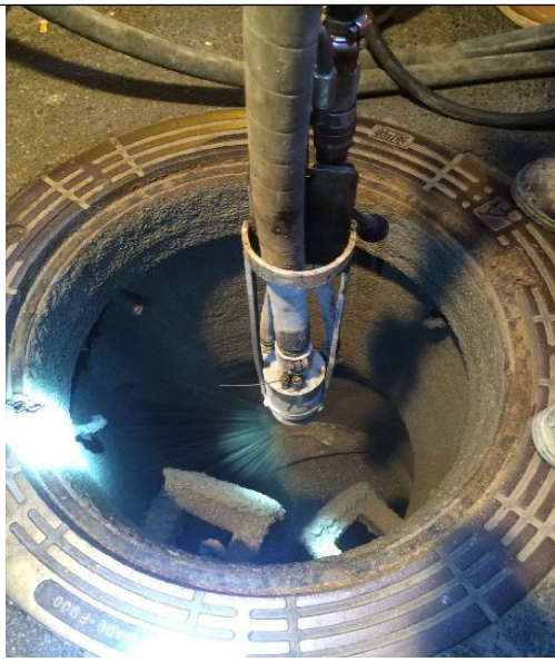
污水检查井修复过程照片
